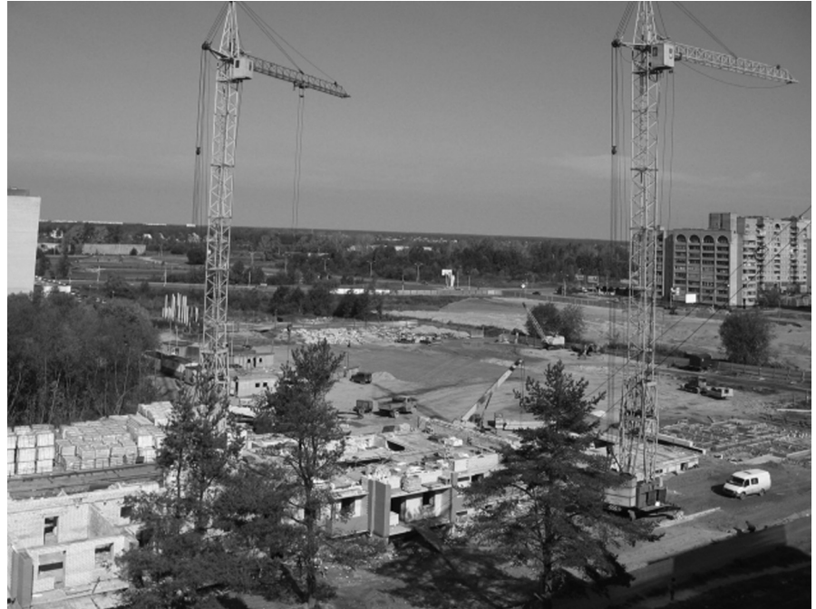
Начато строительство жилого дома для программистов
